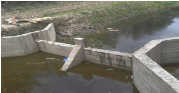
Gambar 3. Canal blocking yang siap digunakan untuk menampung air
