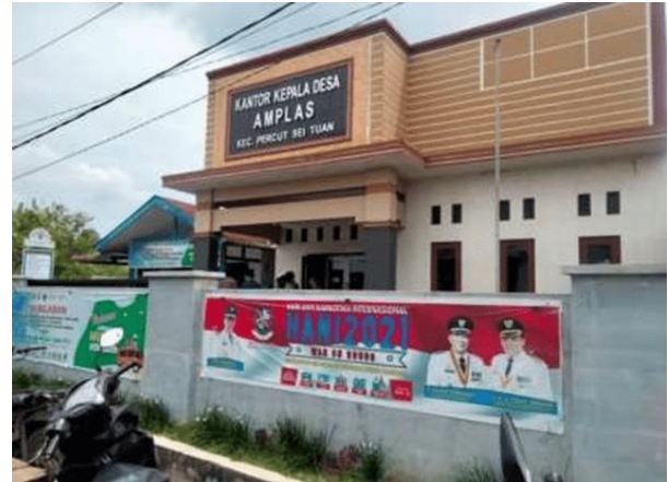
Gambar 2. Kantor Kepala Desa Amplas, Kecamatan Percut Sei Tuan.
