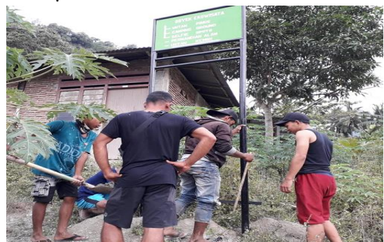
Gambar 12. Pemasangan Sarana penunjang ekowisata.
