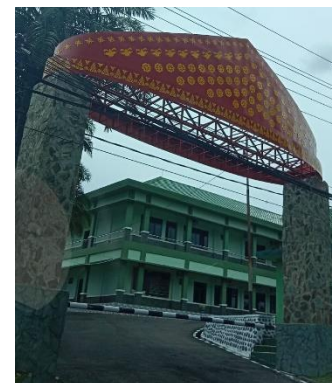
Gambar 6. Implementasi Motif Songket Berbentuk Tanjak pada Gedung Korem 044 Garuda Dempo Kota Palembang. Media Aluminium Composite Panel
