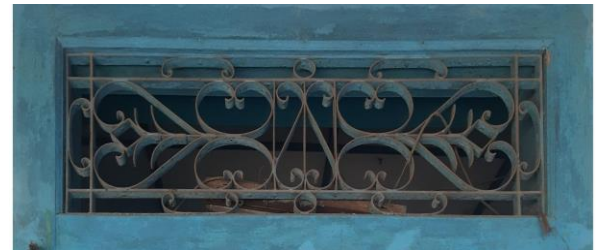
Gambar 9. Elemen Estetis pada Atas Pintu/Jendela pada Rumah Peranakan, Jamblang
