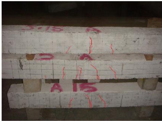
Gambar 4.1 Pola retak balok uji I
