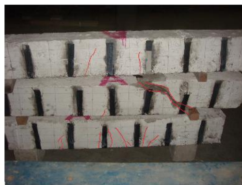
Gambar 4.4 Pola retak balok uji IV
