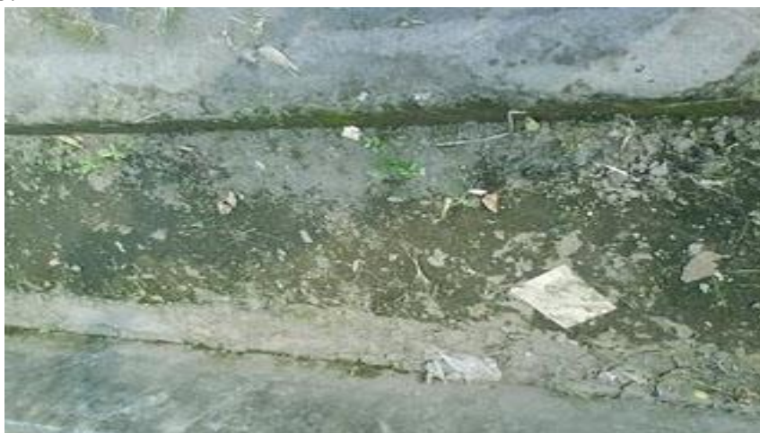
Gambar 3. Kondisi saluran drainase yang tertimbun
