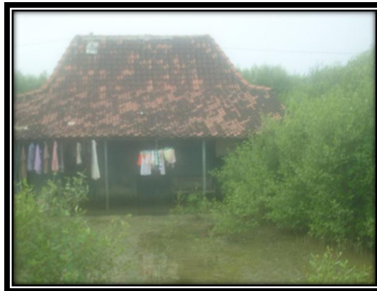
Gambar 7. Permukiman yang terendam air laut sebagai dampak sea level rise
